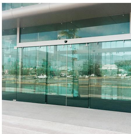
Sistema Herralumatic 2<sup>o</sup> Generación, diseñado con capacidad de hasta 120kg por hoja o 100kg en dos hojas, con un gabinete de 5m de largo. Con vena antivibración y riel curvo con tapa desmontable que facilita el mantenimiento.
